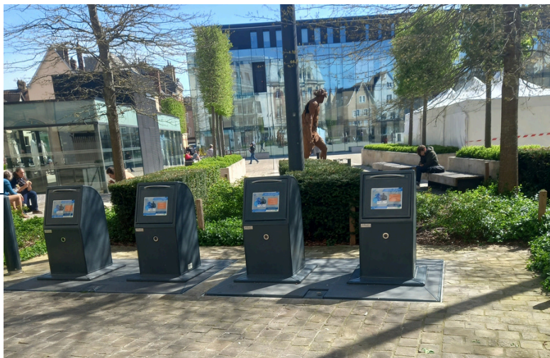
Colonnes enterrées - Ville de Chartres
