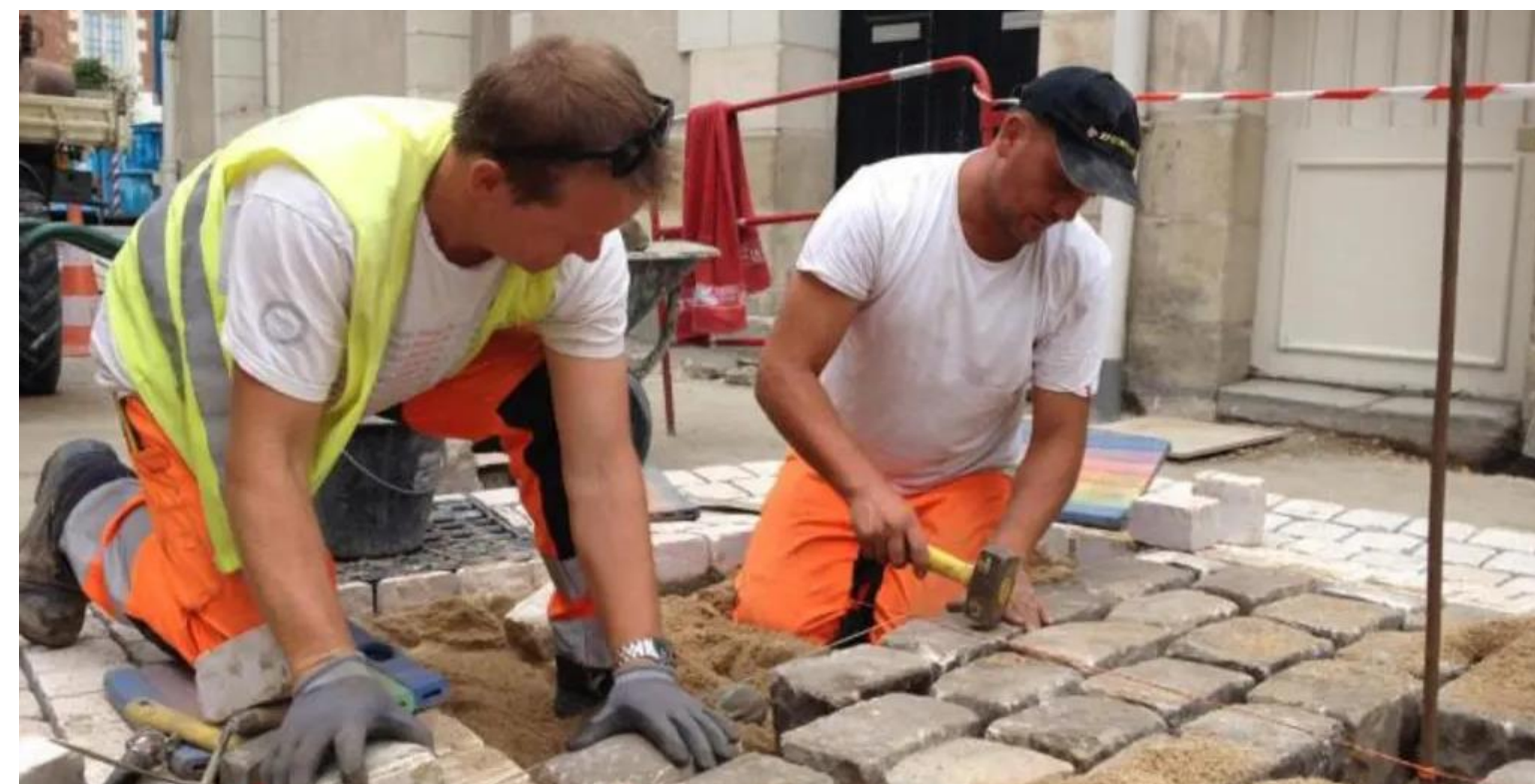
> Tours, pose de pavés anciens sur lit de sable
